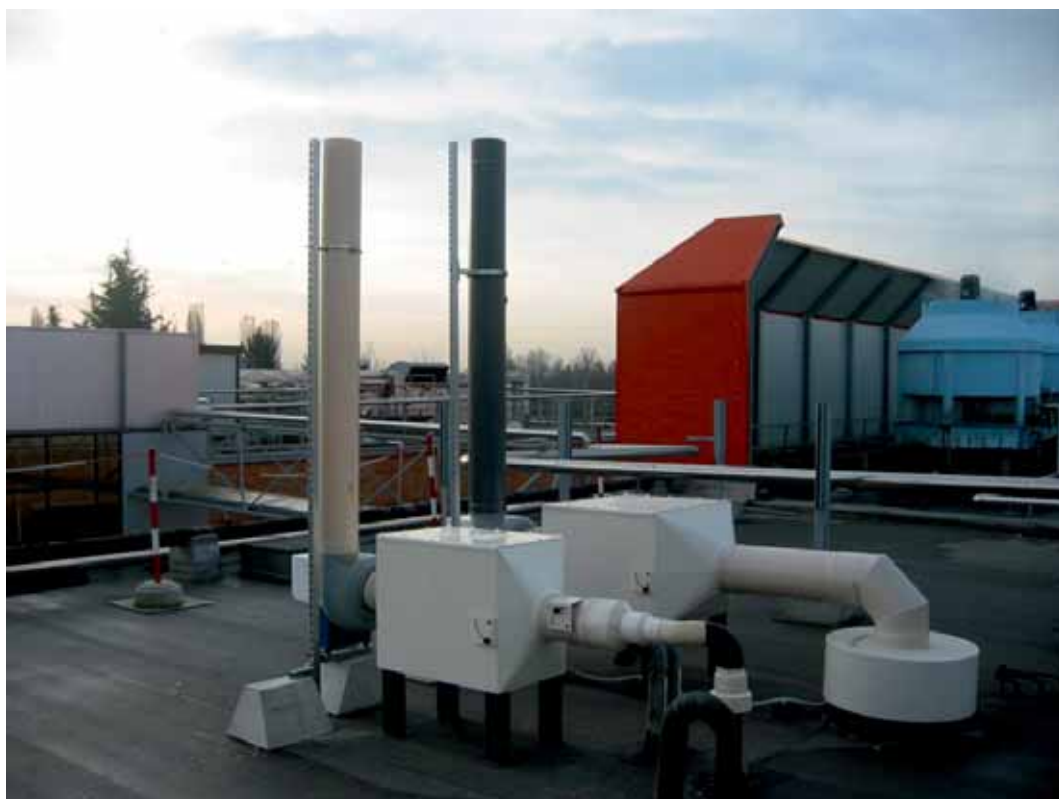
Esempio di installazione di un cassonetto PROJECTCARBO con elettroaspiratore
